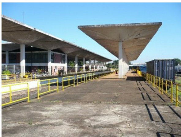
Foto da estação ferroviária de Ribeirão Preto (SP) postada no 'Arquiografia'. A ideia do site é reunir diferentes visões da arquitetura do espaço urbano brasileiro. (foto: Artur Rozestraten – CC BY 3.0)
